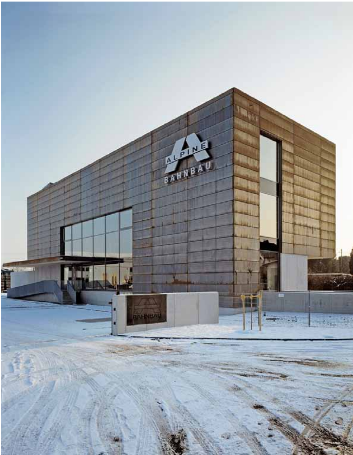
Alpine Bahnbau | Traun | Fertigstellung 2009
